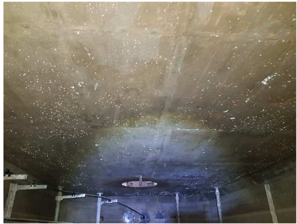
내용 상부슬래브 상태양호
