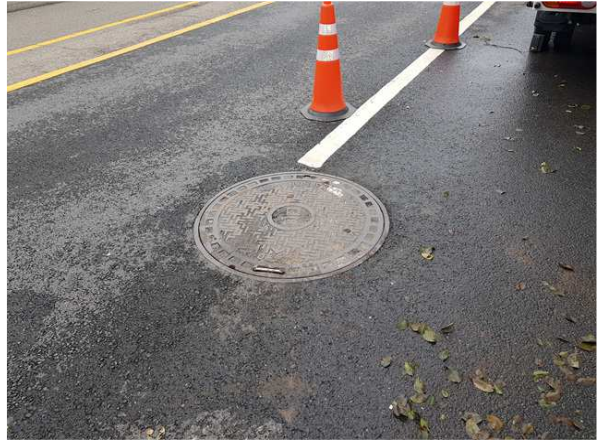
내용 포장부 아스콘망상균열 보수부 전경
